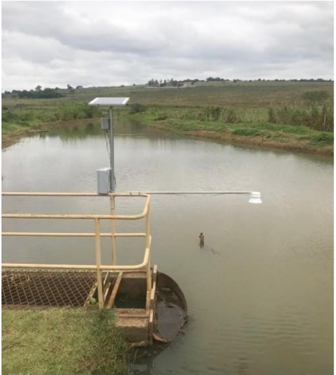
Sensor para medição de nível da captação de água em riacho
